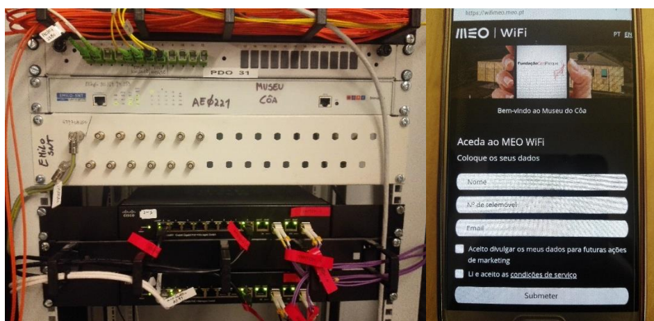
Instalação de rede Fibra/LAN e disponibilização de rede Wi-Fi para todo o edifício do Museu do Côa.
